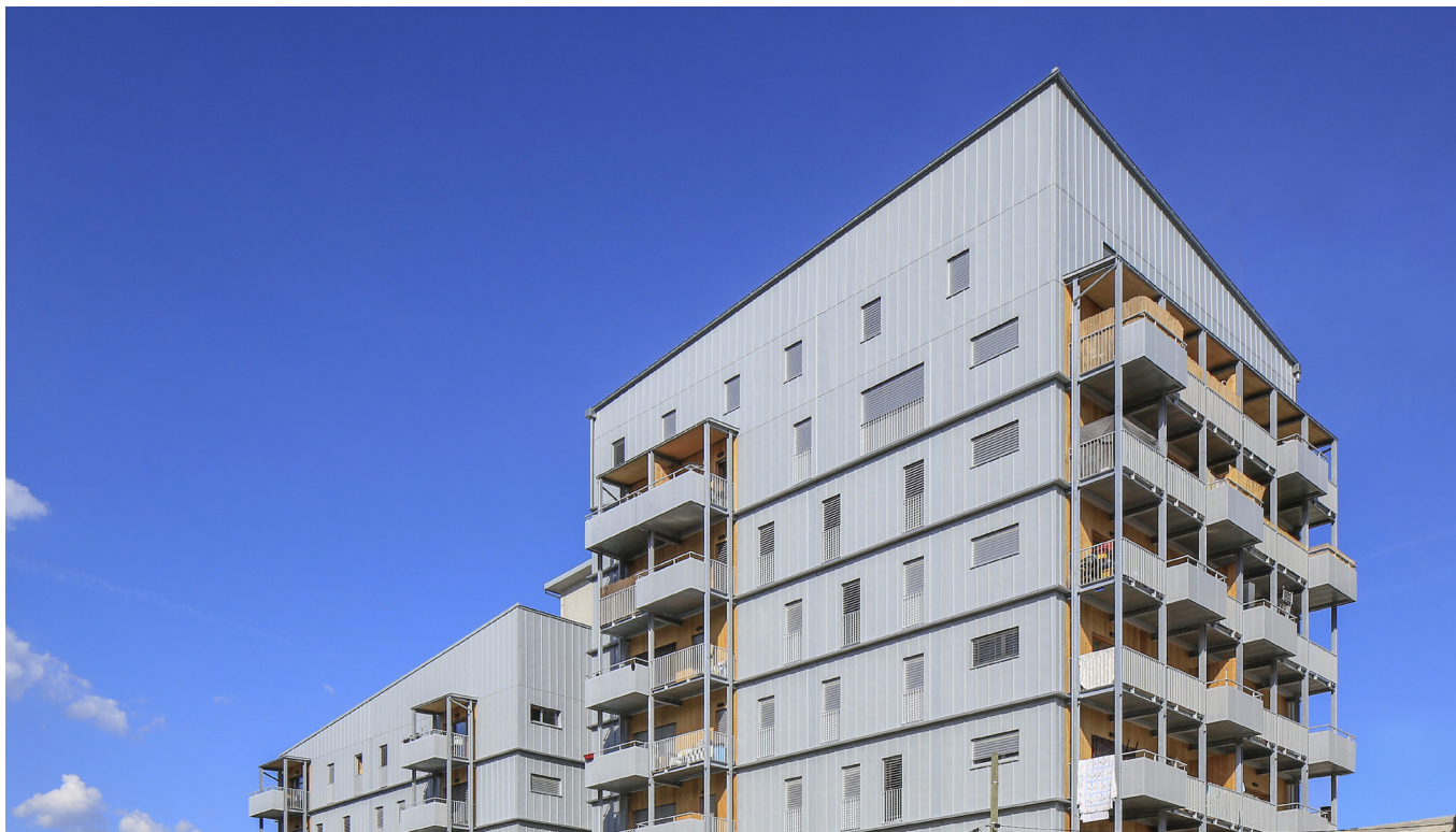
Logements les Hauts Bois, Grenoble (France) - Architecte : ASP Architecture (mandataire), Atelier 17C (cotraitant), St Dié des Vosges (88) - Entreprise : SDCC - 38
